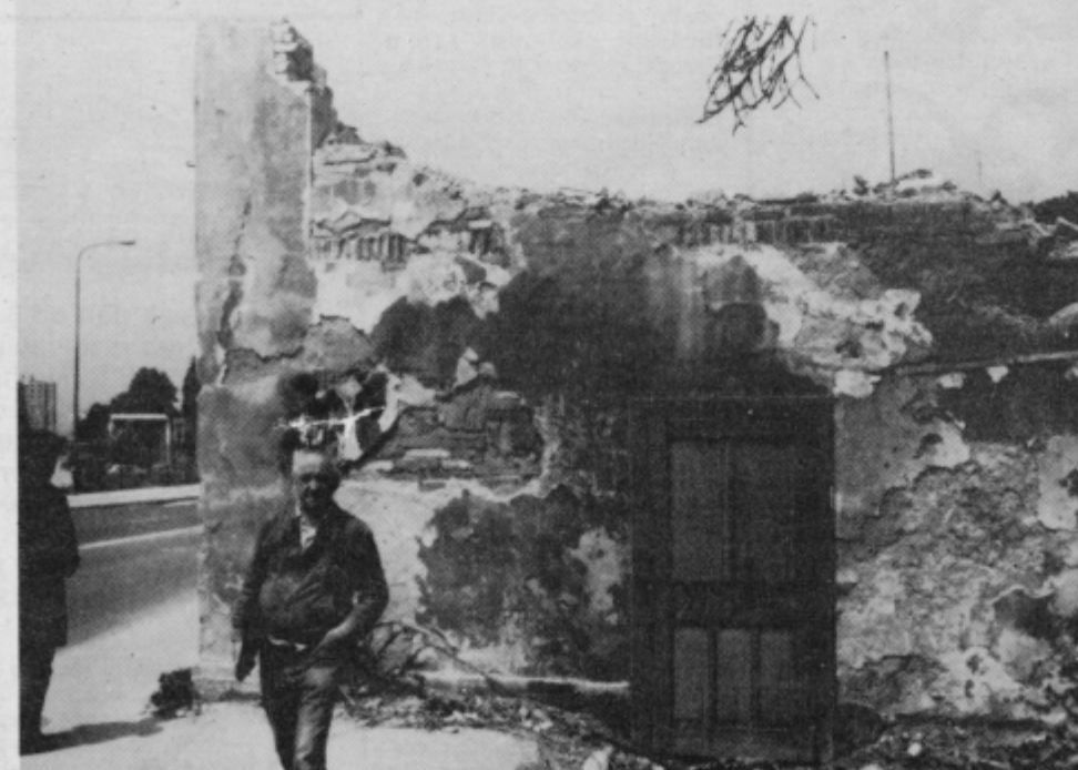
Ko se je zrušil strop stavbe ob križišču Mariborske in Dečkove ceste (pri Libeli), je v ruševinah ostalo za skoraj milijon dinarjev materiala in orodja obrtnika Franca Štumbergerja.
