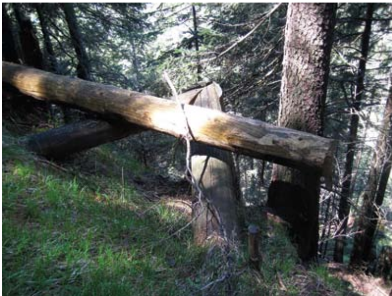
Tripodi, uporabljeni za ustavljanje drsenja snega in s tem preprečevanje poleganja mladih sadik
