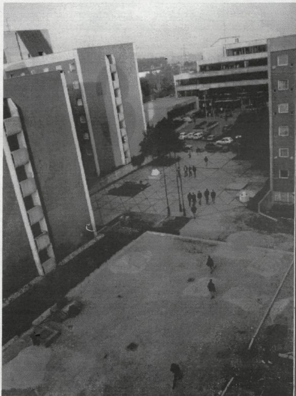
Asfaltirana betonska parkirišča bodo prebivalcem študentskega naselja na Kardeljevi ploščadi še "polepšala" bivalni prostor.
