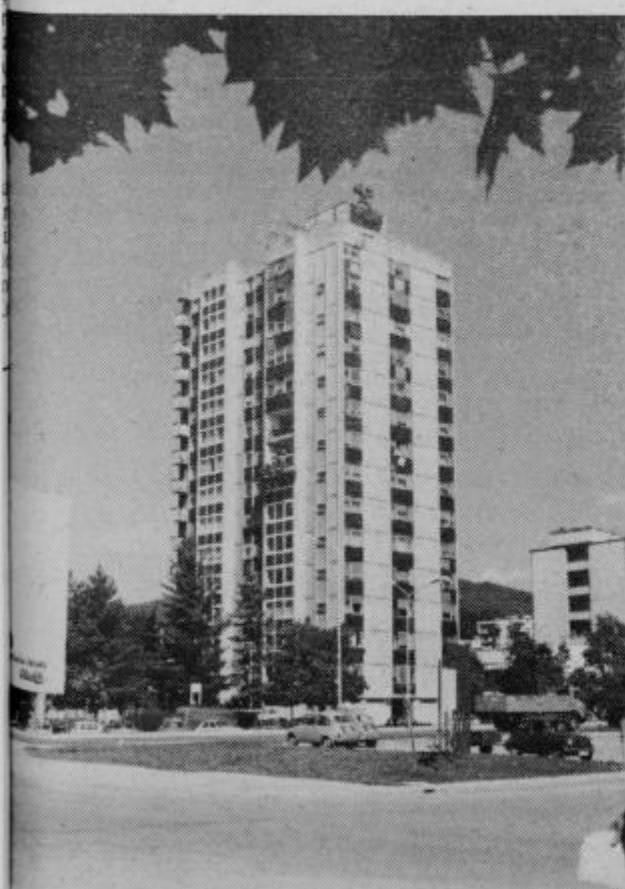
Stalpnica v Titovem Velenju, v katero delavci vgrajujejo Kostrojeva PVC okna.
