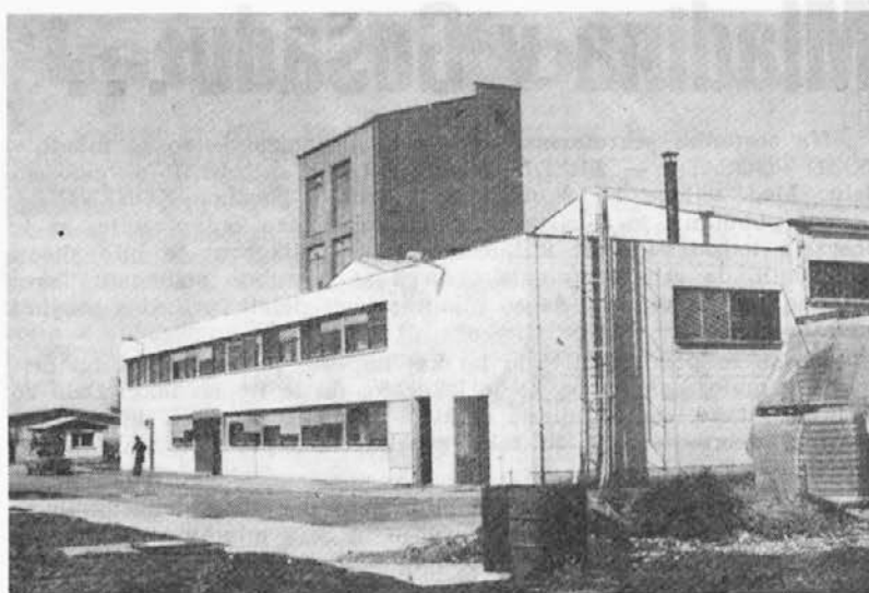
Proizvodni prostori v GOSADU, zgrajeni 1977/78 leta!
