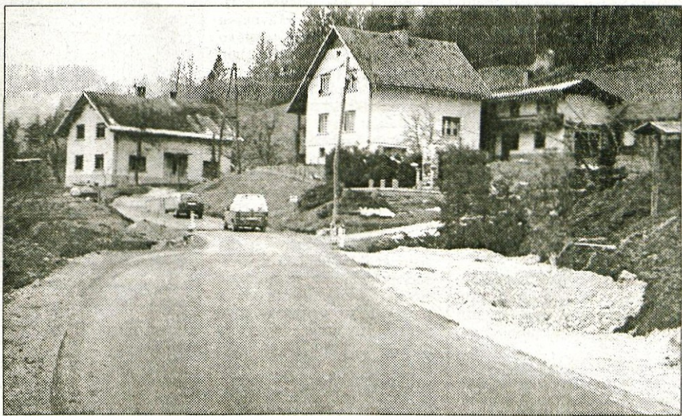
Priprava na gradnjo mostu pred Žirimi
