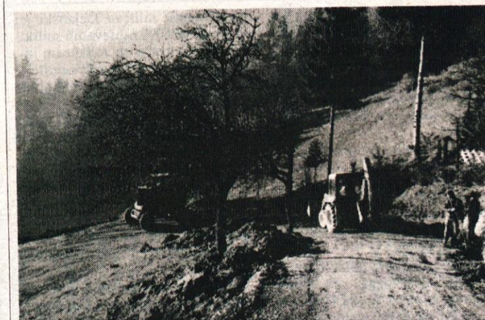
DELA NA CESTI HORJUL — KORENA ZASTALA — Na cesti Horjul — Korena so že v začetku zime brneli stroji ter razširili staro ozko makadamsko cesto in opravili glavna zemeljska dela do odcepa ceste za Samotorico. Delavci cestnega podjetja Ljubljana so stroje odpeljali, ker novonastala občina najbrž nima denarja. Korena pa se je z asfaltom približala za kakih 1600 m, kolikor so ga položili z vrha Korena proti Horjulu. (Besedilo in foto France Brus)
