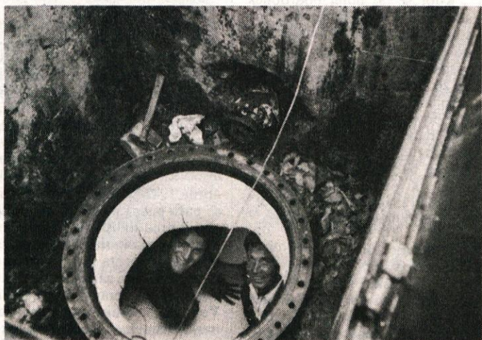
Vgraditev dodatnega plašča v rezervoar za kurilno olje.
