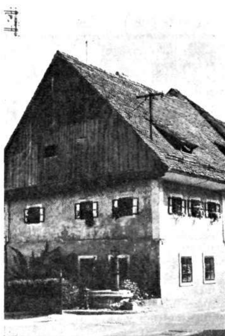
Zeblijarjeva hiša z lesenim nadstropjem na Lontrku
