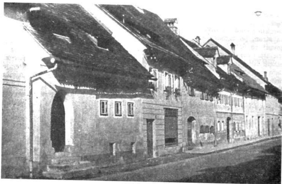
Grohcova hiša na Lontrku pred neustrezno obnovo; del stavbe »hiša« je lesen; kmečka oblika arhitekture je nastala verjetno po požaru 1698
