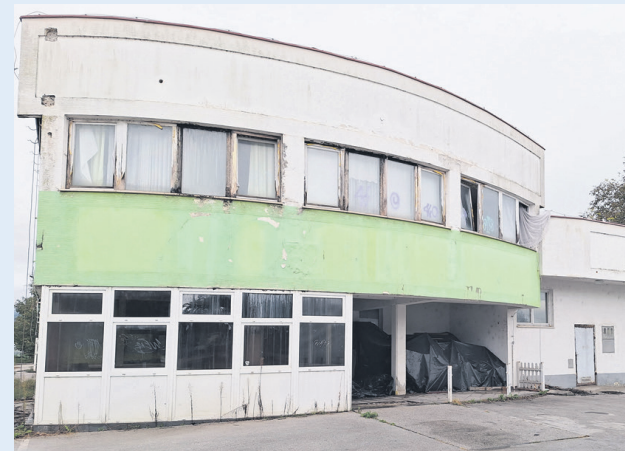
V občini Polzela v oči bode zapuščena Mercatorjeva zgradba v bližini tovarne nogavic. Se bo le našel kupec zanjo? (Foto: ŠO)
