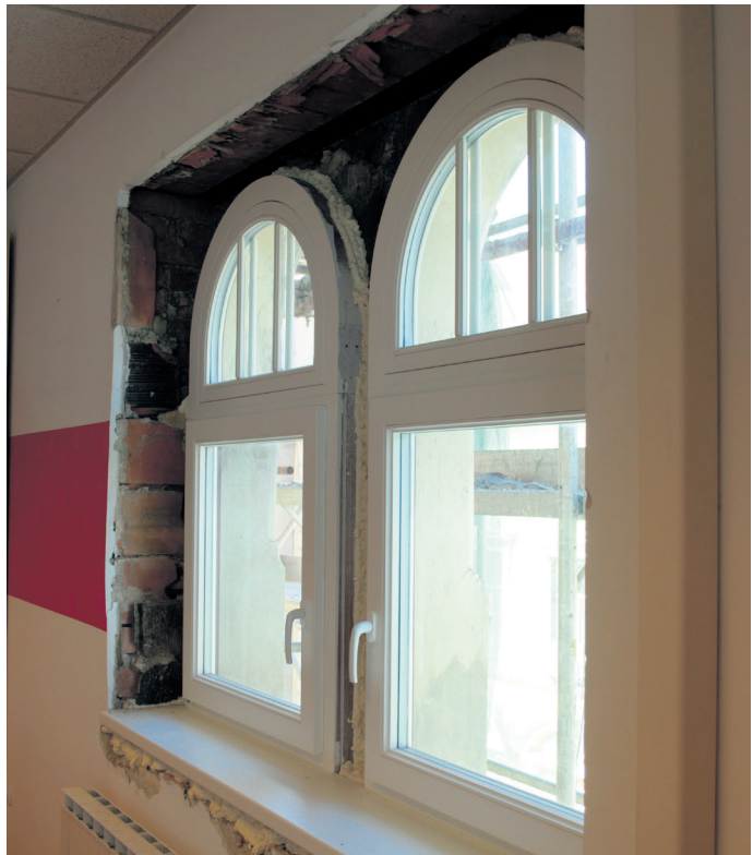
Menjava oken v Celjskem domu med energetsko prenovo je bila poseben izziv. (Foto: arhiv Energetike Celje)
