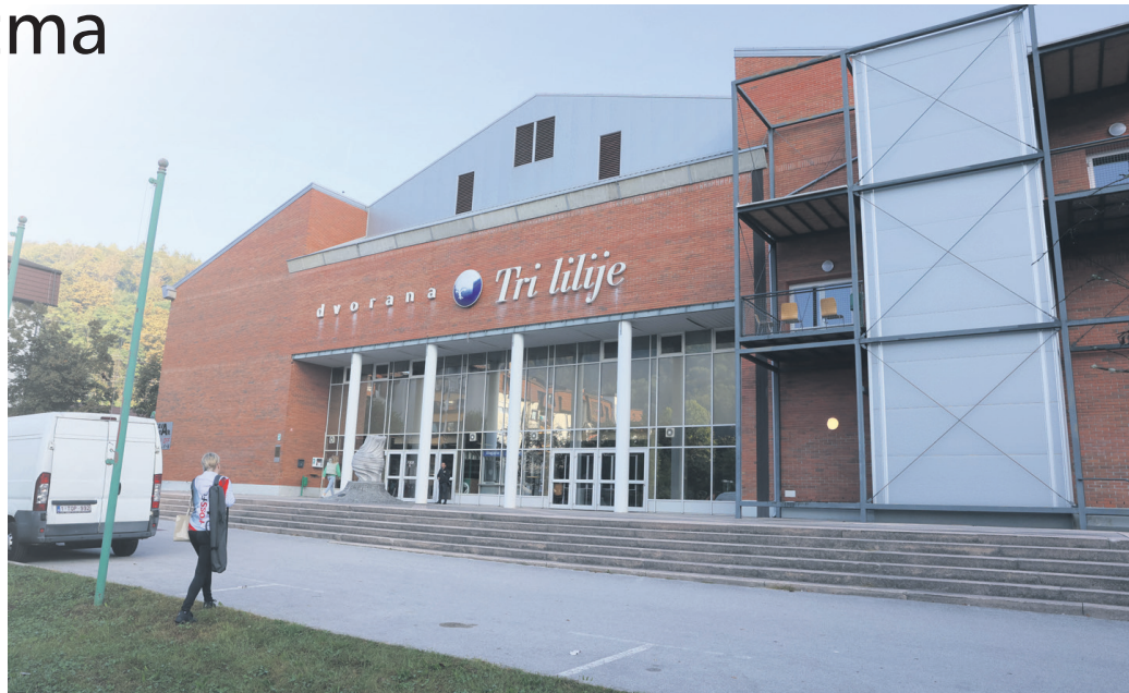
Športno dvorano Tri lilije čaka posodobitev. Dobila bo nov parket in sodobnejši sistem za ohlajevanje dvorane. (Foto: Andraž Purg)
