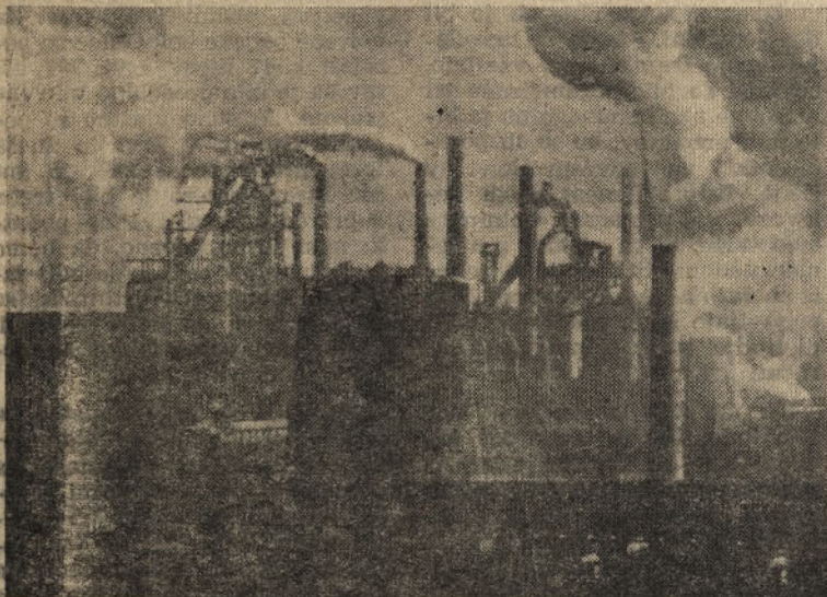
Pogled na visoke peči železarne v Trincu
