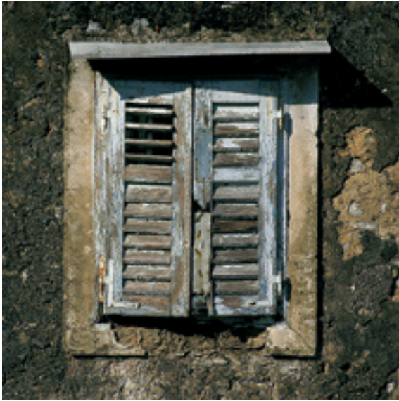
Slika 40: Okna in steklene stene so najpreprostejši in tudi najbolj razširjeni element naravnega ogrevanja stavb, vendar jih je treba zaradi pregrevanja poleti zastirati. (Foto: Stane Crnjak.)
