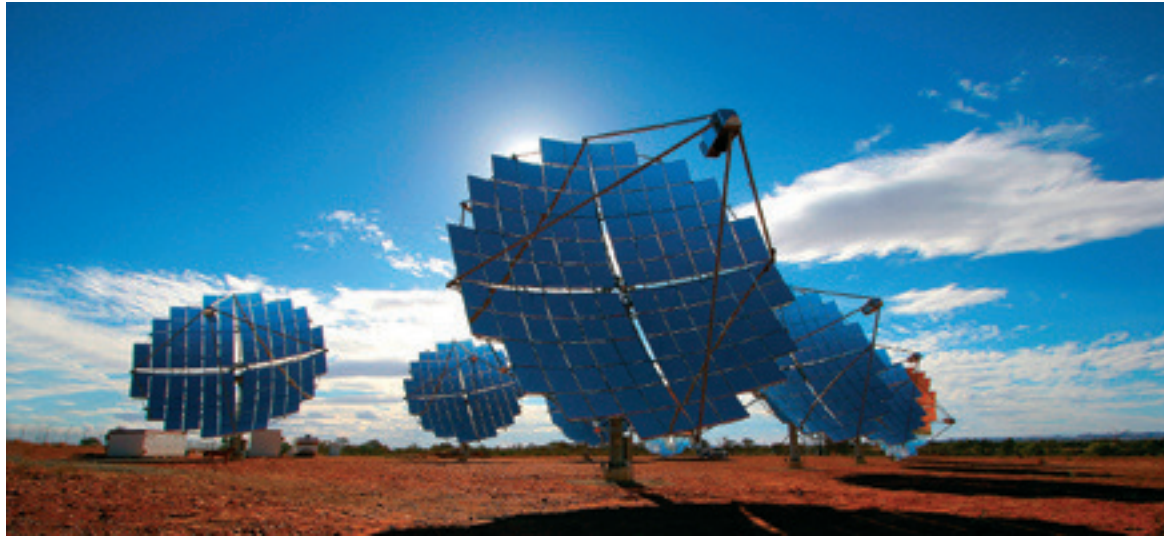
Slika 33: Le redka območja so primerna za velike sončne elektrarne, kot je ta v Hermannsburgu v Avstraliji. (Foto: Curtis Morton.)
