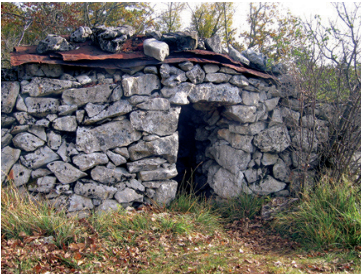
Slika 7: Nekdanja pastirska hiška v okolici Pliskovice, zgrajena iz kamnja, na suho ter brez malte. (Foto: Miha Pavšek.)
