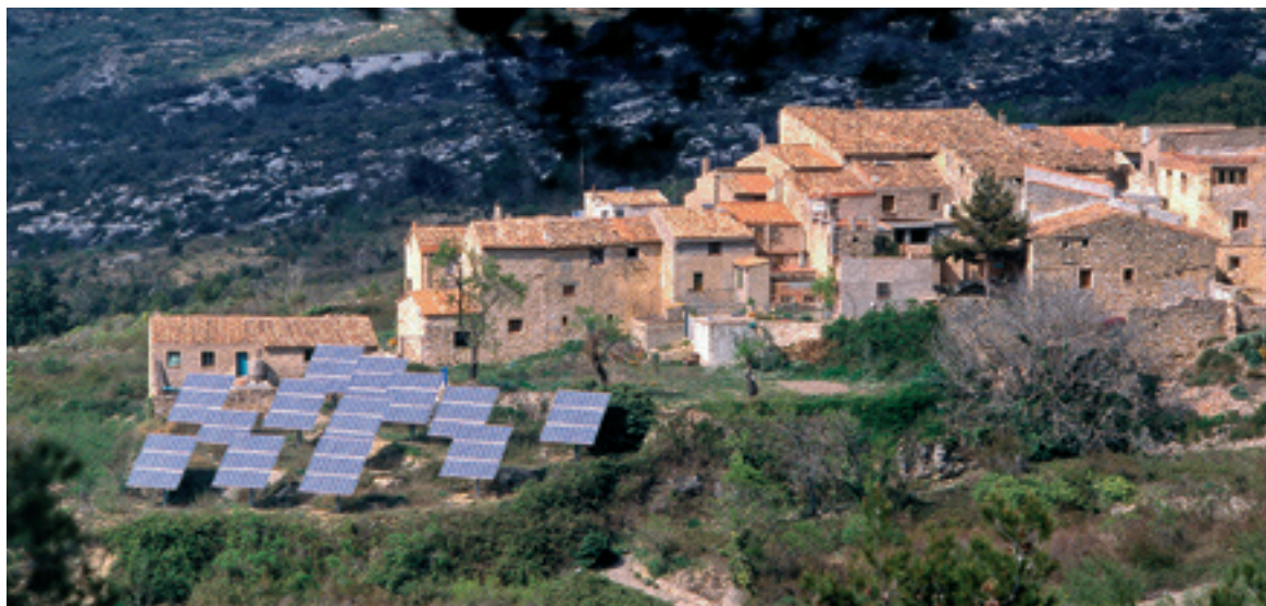
Slika 34: Kljub temu da smo določali primerna območja za energetske varčne novogradnje in sončne elektrarne, lahko sončno energijo izkoriščamo tudi na že obstoječih stavbah ali v njihovi bližini. (Foto: ©Evropska unija.)
