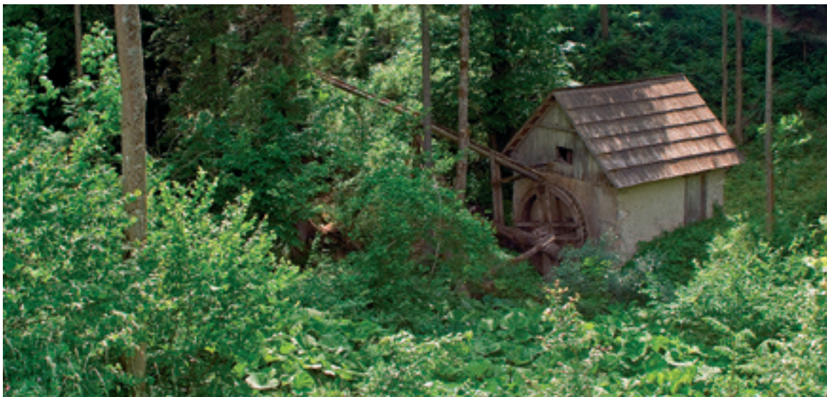
Slika 2: Izkoriščanje vodne energije se je na mlinih in žagah uporabljalo že v preteklosti. Na fotografiji je Brčunov mlin ob potoku Voložnica v Rovtu pod Menino. (Foto: Žiga Kokalj.)
