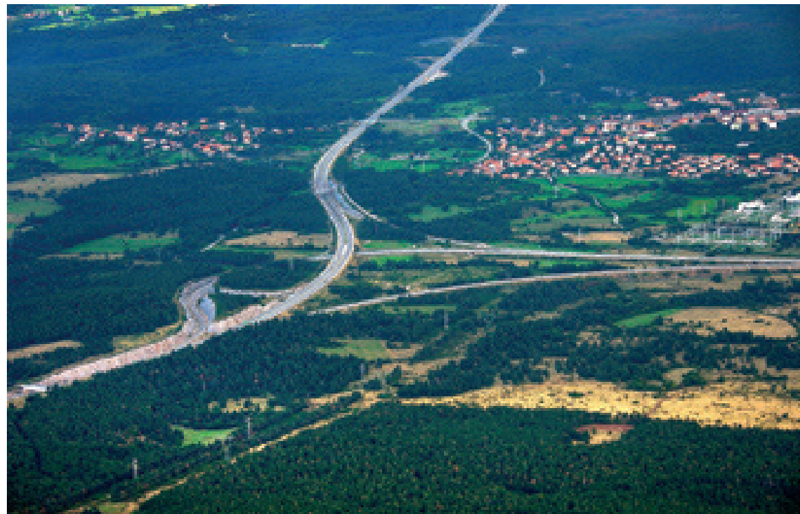
Slika 98: Območje Divače je izrazito obremenjeno s prometno in energetsko infrastrukturo. (Foto: Matevž Lenarčič.)
