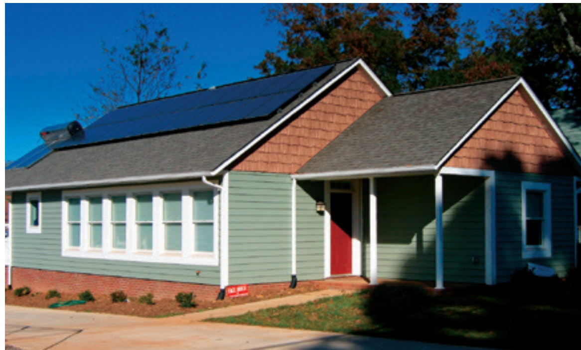
Slika 43: Fotovoltaični moduli in sprejemniki za gretje vode na energijsko uravnoteženi hiši, ki vso energijo za svoje »delovanje« pridobiva iz obnovljivih virov. (Foto: Sarah Bear.)
