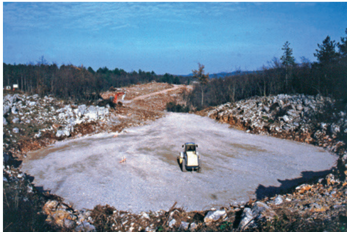
Slika 70: Zapolnjevanje vrtače z gruščem. Iz vrtače so najprej odstranili naplavine. Danes je pod avtocesto med Kozino in Divačo. (Foto: Tadej Slabe.)
