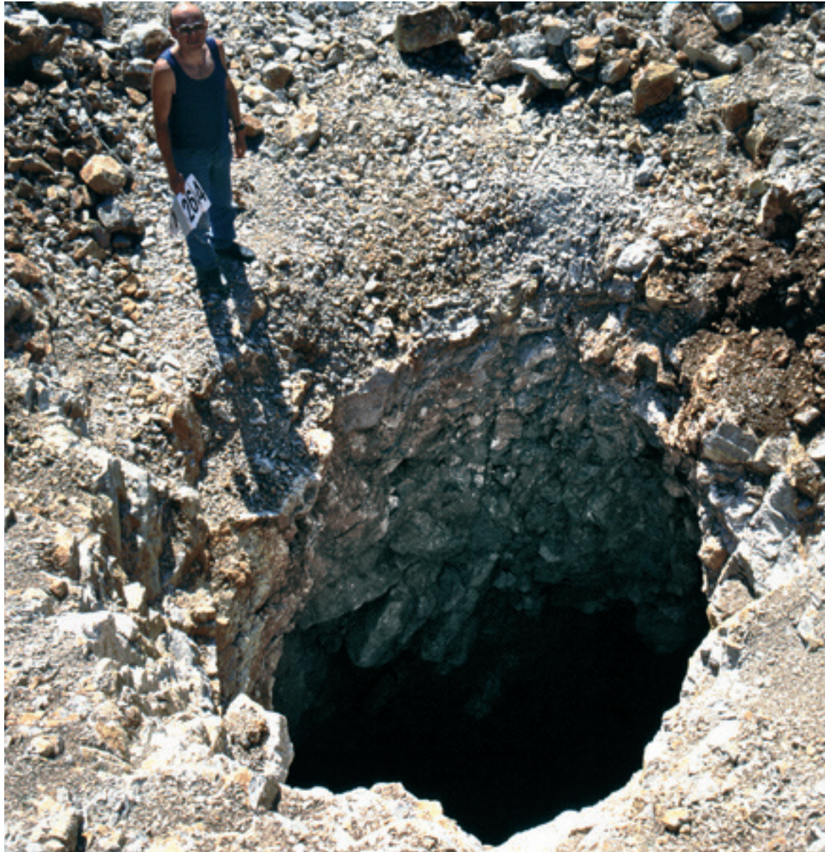
Slika 75: Udor stropa jame pri gradnji useka pri počivališču pri Divači. (Foto: Tadej Slabe.)
