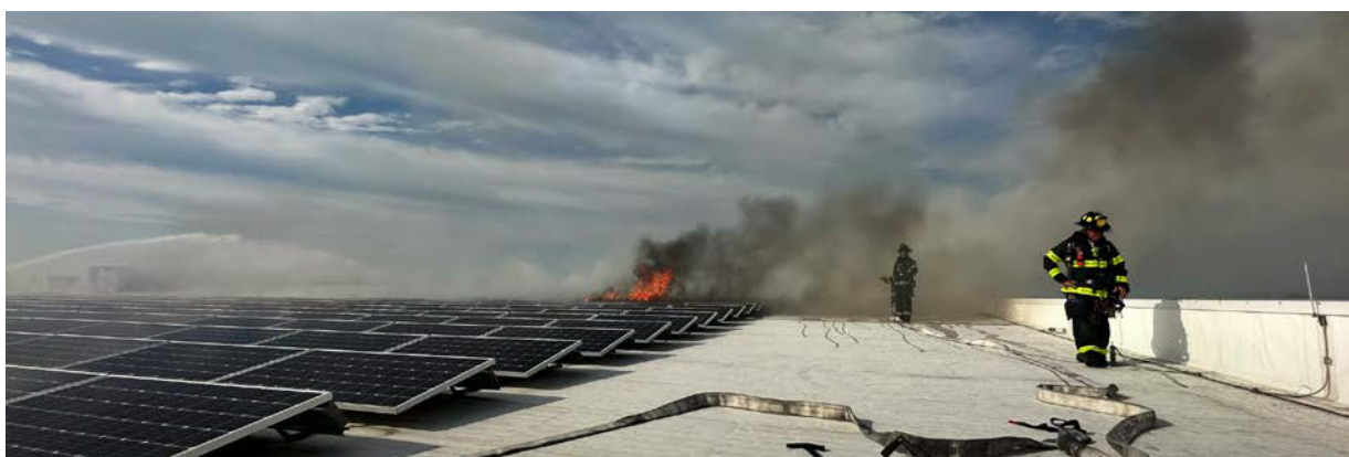
Fotografie střechy a zasahujících hasičů pořízená v Robbinsville, New Jersey, USA.
