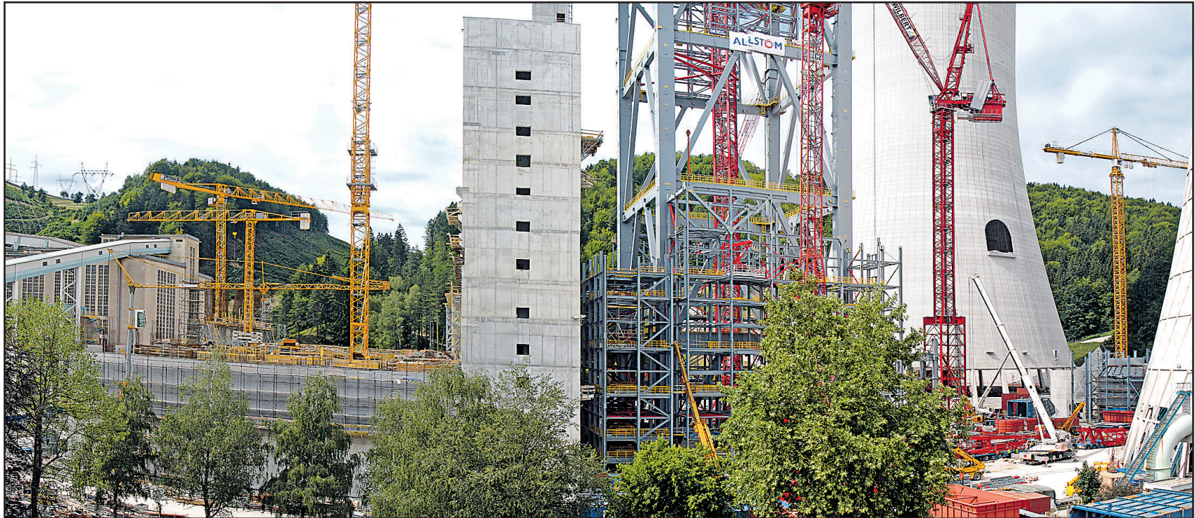
Turbinska hala, jeklena konstrukcija, hladilni stolp in desno ob njem začetek gradnje čistilne naprave.
