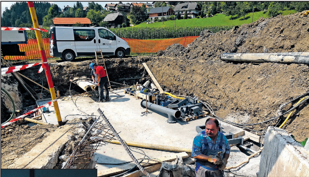
Največje gradbišče je bilo v Pohrastniku
