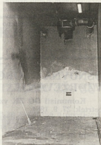
Počrnel strop v prvi mešalni celici po požaru.
