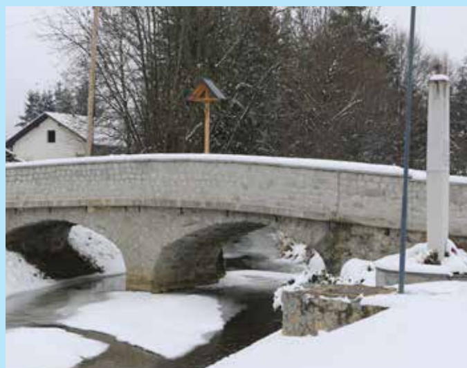
Prenova kamnitega mostu v Loki pri Mengšu
