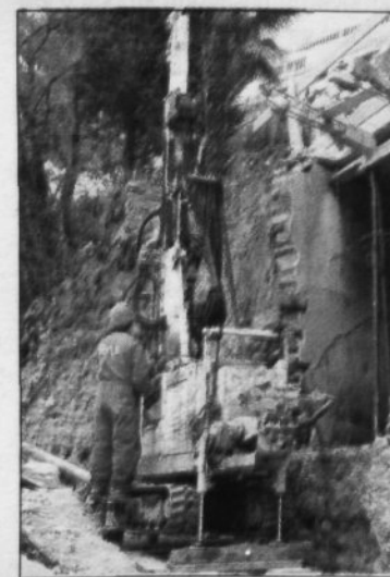
Vrtalna garnitura za izdelavo geomehanskih vrtin
