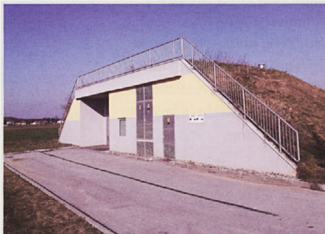
Strojnica namakalnega sistema
