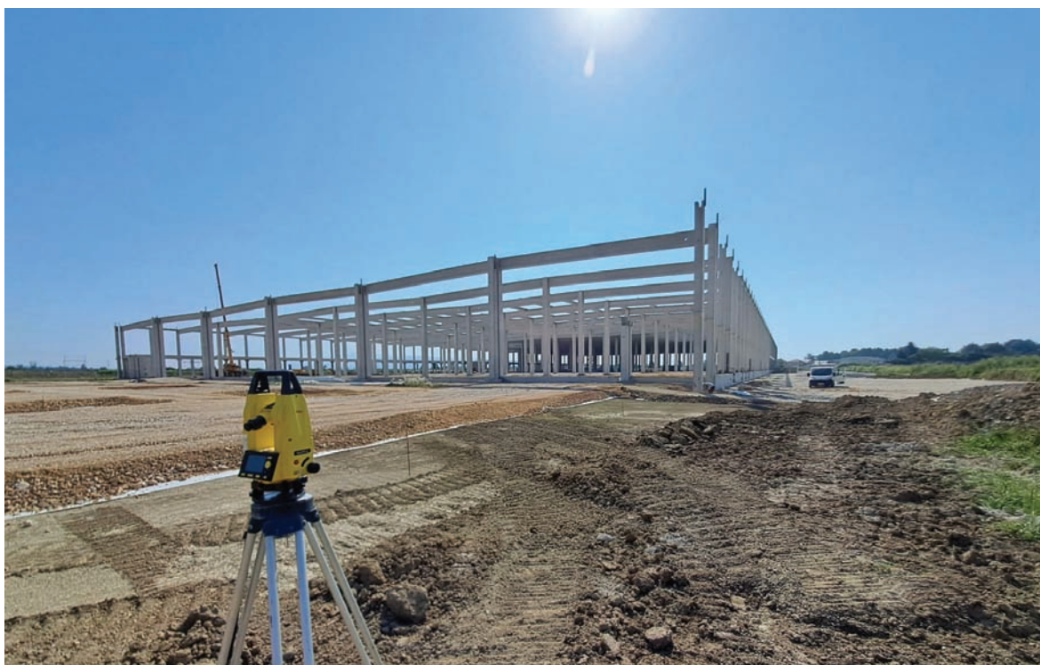
Slika 4. Ko je steber postavljen v časo temelja, se pritrdi s hrastovimi klini in s pomočjo teodolita postavi v vertikalo.
