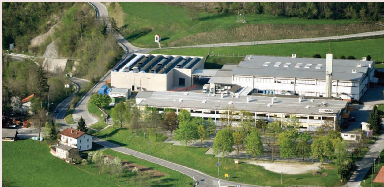
› ITW Metalflex svojo dejavnost še danes opravlja v stavbi, ki so jo zgradili leta 1979. Lokacija se je do današnjih dni še precej razširila in predstavlja večji del industrijske cone na Poljubinskem polju v Tolminu. (Foto: Tatjana Šalej Faletič)
