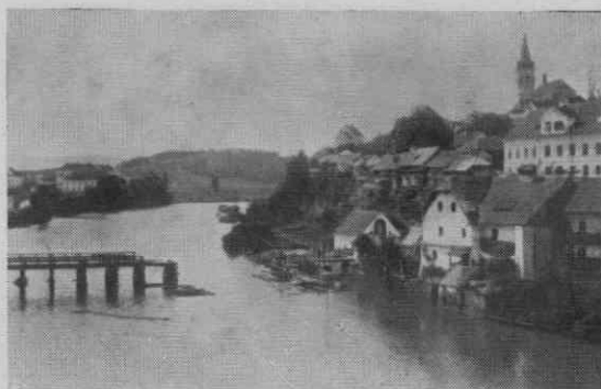
Novo mesto l. 1899 o priliki rušenja starega lesenega mostu (Foto K. Clarici)
