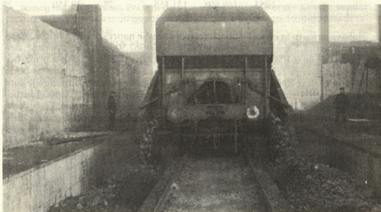
Praznjenje vagonov tipa Fads-z na terminalu (foto Arzenšek)
