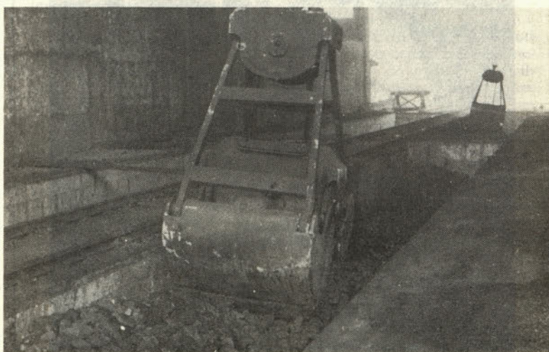
Praznjenje terminala z grablci in prenos v bunkerje (foto Arzenšek)
