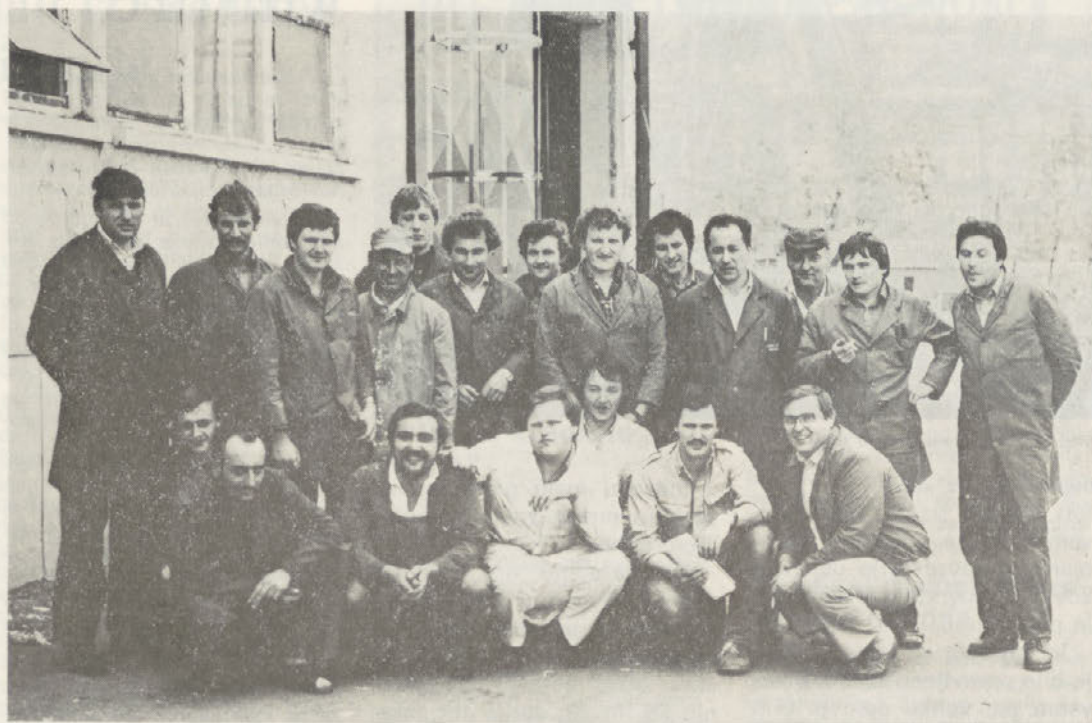
Del skupine delavcev pri obnovi klavnice med prazniki. Drugi z desne čepi Andreas Jansen Storkov serviser
