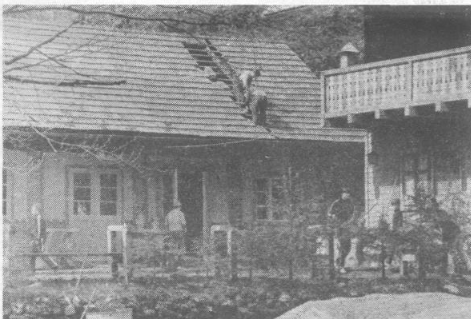
Popravilo doma pred skorajšnjim rušenjem
