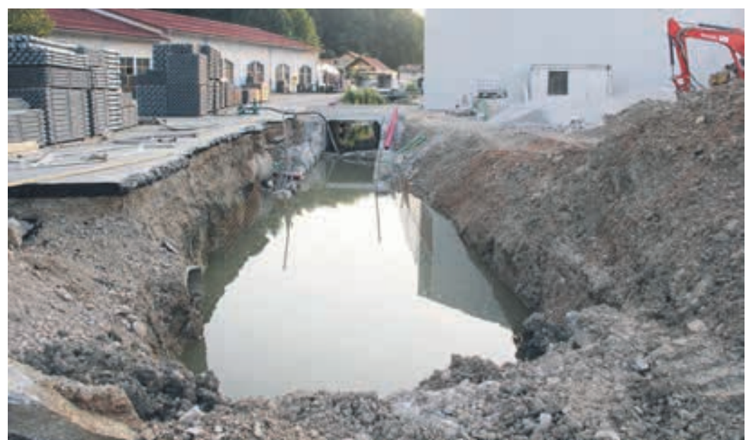
Gradbišče pri podjetju Huliot.
