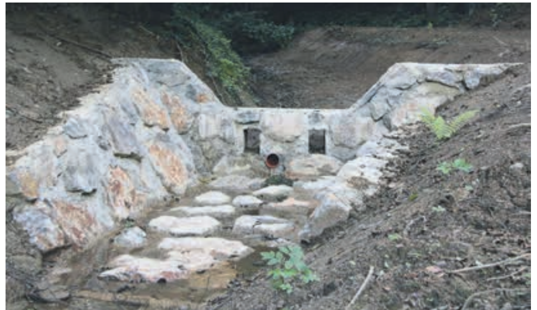
Velik zadrževalnik hudourniških voda čisto na začetku vodotoka.
