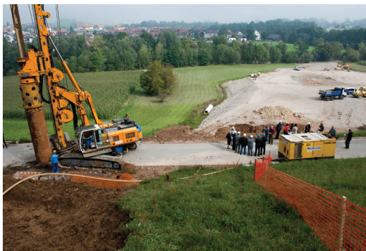
Začetek gradnje poljanske obvoznice na severnem portalu predora Pod Stenom, (22. 9. 2010).
