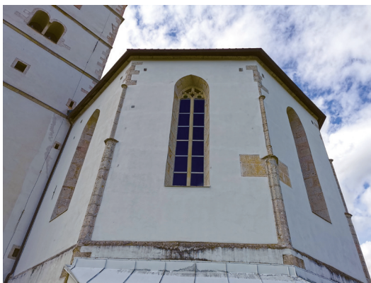
Ventilacijske mrežice. (foto: Jože Štukl)
