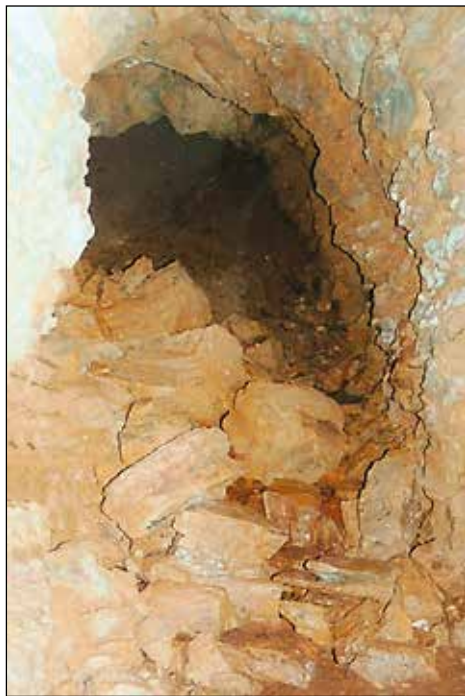
Slika 3: Konec rova s podorom, oktober 2005. Foto: Bojan Kofler
