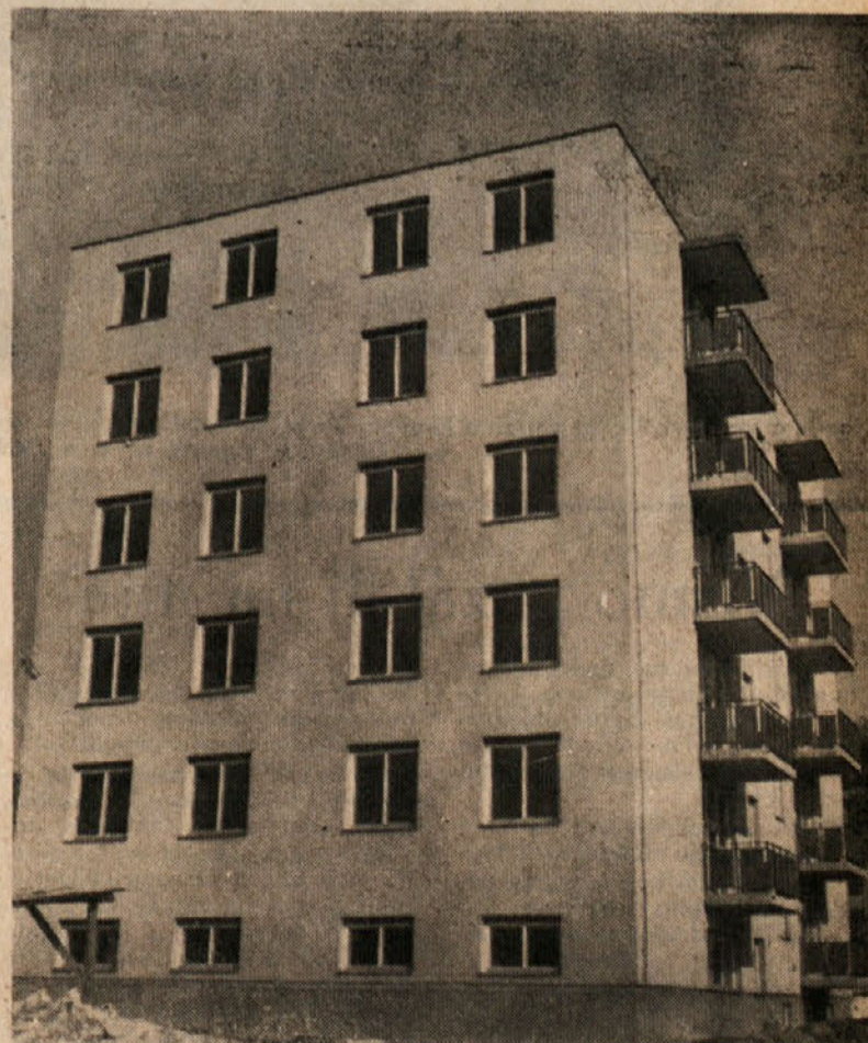
V Ljubljani na Prulah smo zgradili dva stolpiča po načrtih Projektivnega ateljeja
