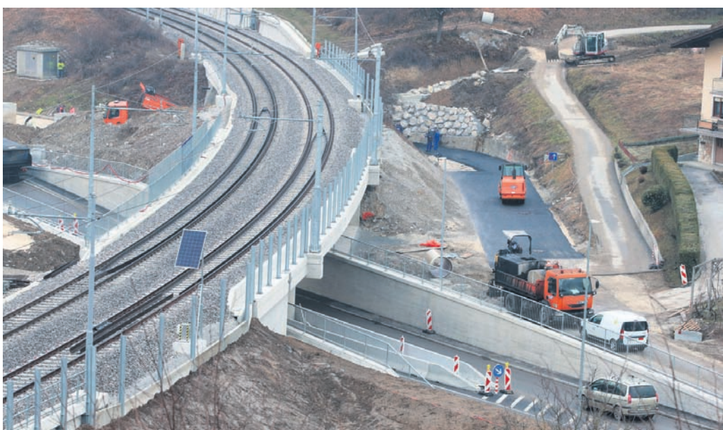
Pri koncu je tudi že gradnja obeh podvozov pod železniško progo v Marija Gradcu.
