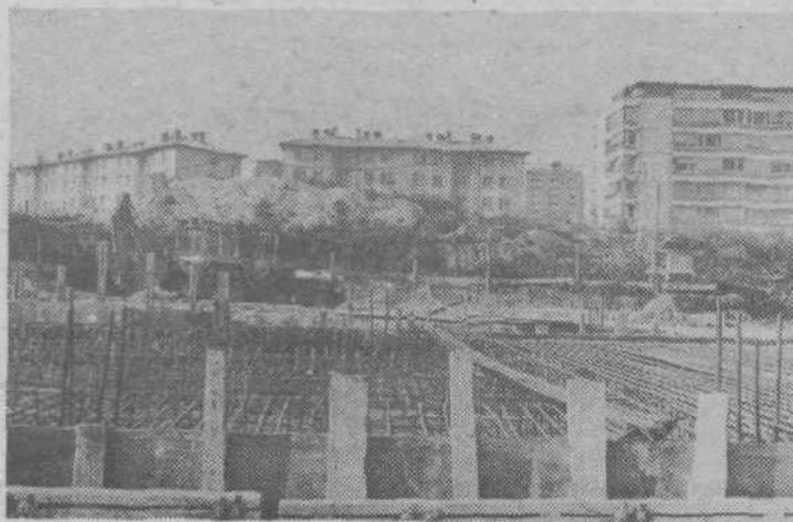
Temelji za VVZ so postavljeni
