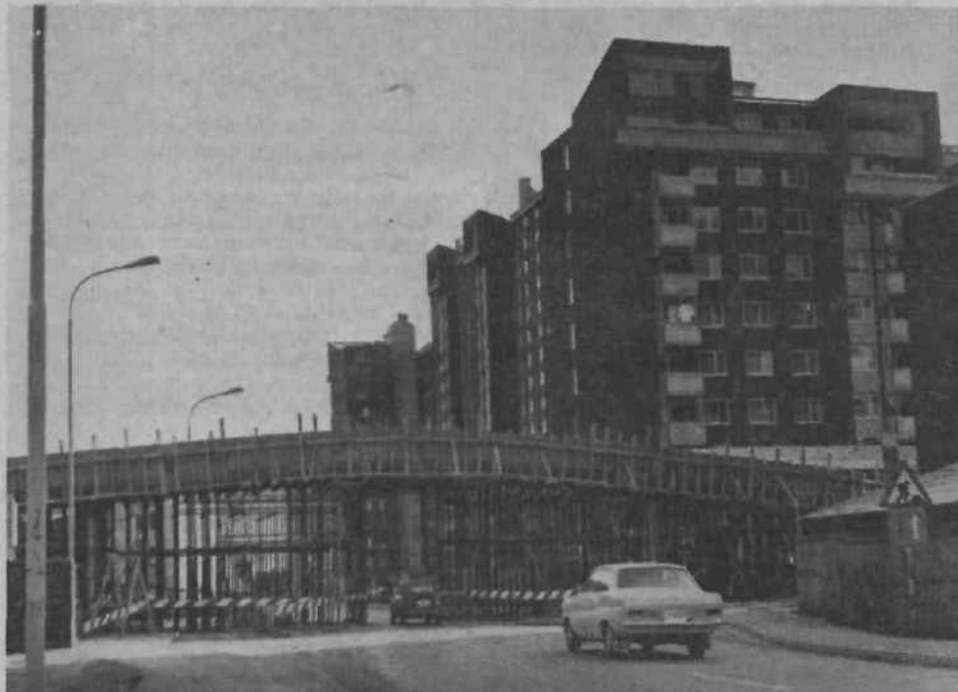
NADHOD ZA PEŠCE – V Soseski 7 gradijo nadhod nad Ulico 7. septembra, ki bo povezoval Glinškovo ploščad in zahodni del Bratovševske ploščadi. Objekt je seveda že dobil ime: pravijo, da je to »most vzdihljajev«.
