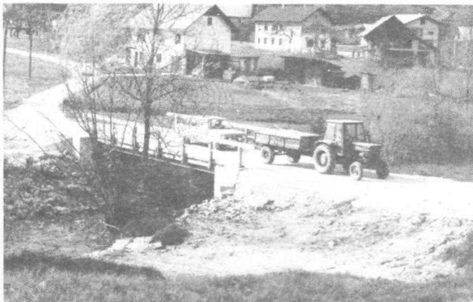
Nov betonski most čez Gradaščico pri Belci omogča krajanom Babne gore ponovno nemoten prihod v svoj kraj
