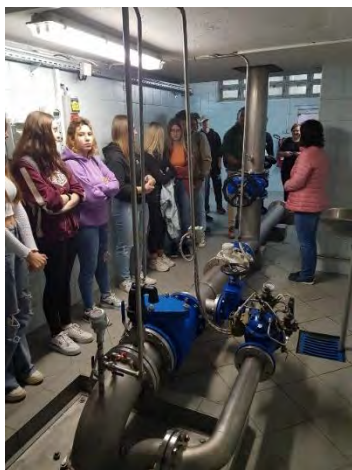
Slika 2. Ogled Vodarne Kleče (Vir: lasten)
