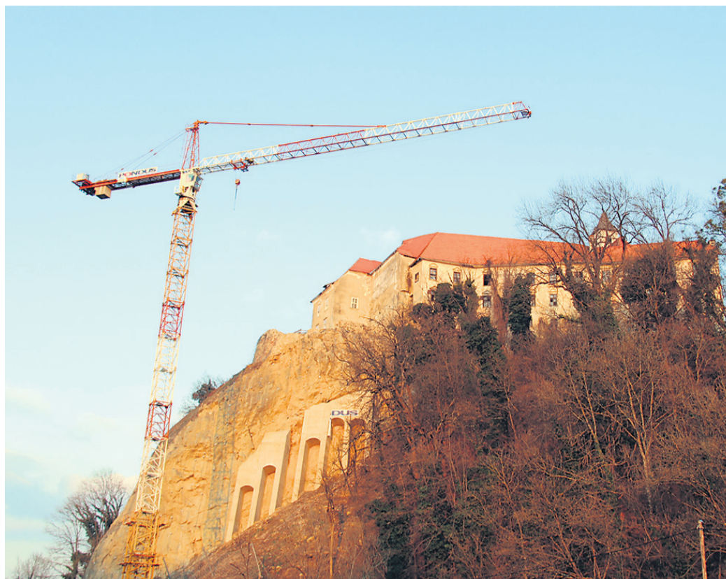
Nestabilno skalo pod gradom, ki se je poleti 2012 okrušila, so sanirali tudi s podpornimi zidovi.
