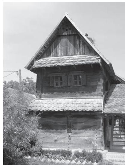
□ **Slika 1. Izkustveno razvita pravila dobre fizične zaščite lesa na fasadi so vidna na hrvaški ljudski hiši – "korablji": les je dvignjen od tal, vodoravni – konstruktivni – elementi so zaščiteni z napušči in nadstreški, obložni elementi (na zatrepu in stopnišču) so položeni navpično.**
