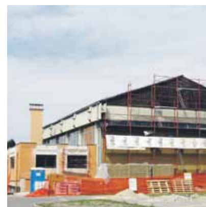
Energetska sanacija telovadnice na OŠ Domžale
