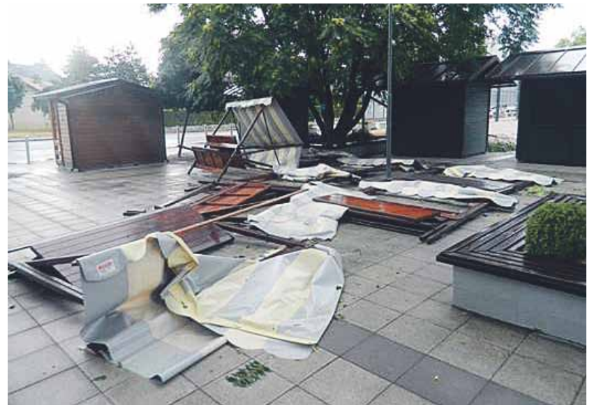
Neurje je poškodovalo stojnice na tržnem prostoru v Domžalah
