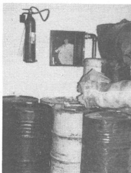
Založen gasilni aparat in zidni hidrant, ki ni zvezan z omrežjem (Silvaprodukt)
