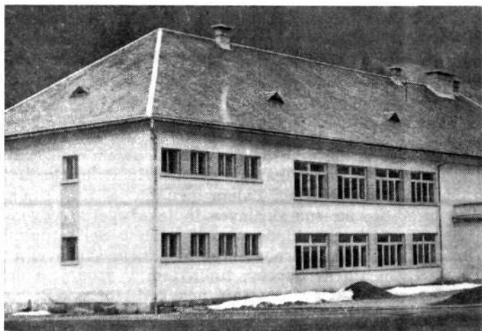
Sl. 20. Železnikarska osemletka, pokrita s strešimi ploščicami iz spodnjejurskega strešnega skrilavca izpod Greblovega vrha
