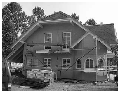
JELOVICA Lesna industrija d.d. Škofja Loka - hiša v gradnji
