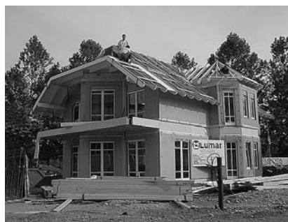
LUMAR hiše d.o.o. Gomilsko - hiša v gradnji
