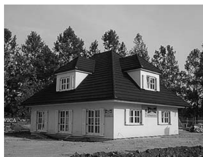
MARLES Hiše d.o.o. Maribor - hiša v gradnji
