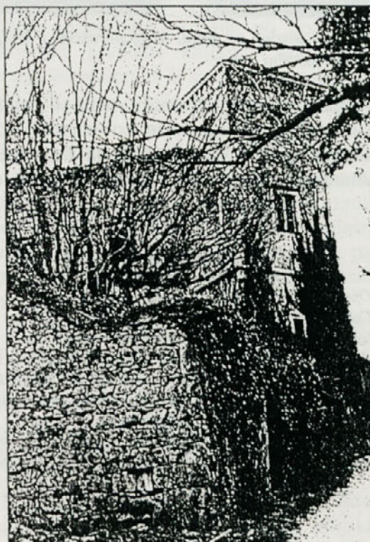
Grad Lože, pogled s severne strani
