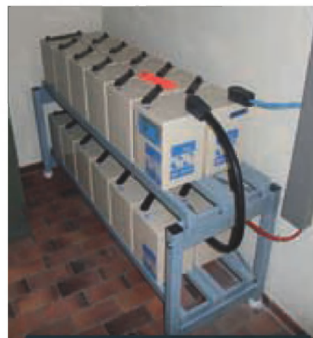
Soba z akumulatorskimi baterijami za rezervno napajanje računalniškega centra mora biti dobro prezračena in izolirana zaradi nevarnih kemikalij v akumulatorskih baterijah.
