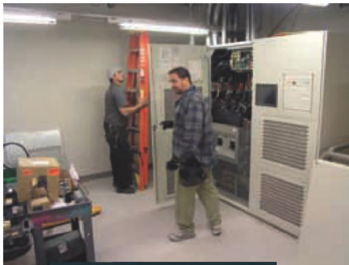
Veliki 500 kVA brezprekinitveni napajalnik
