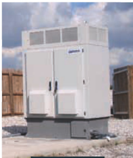
Sistem za napajanje z gorivnimi celicami
