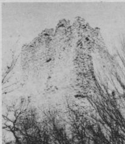
Pogled na razvaline stolpa gradu Kunšperk
