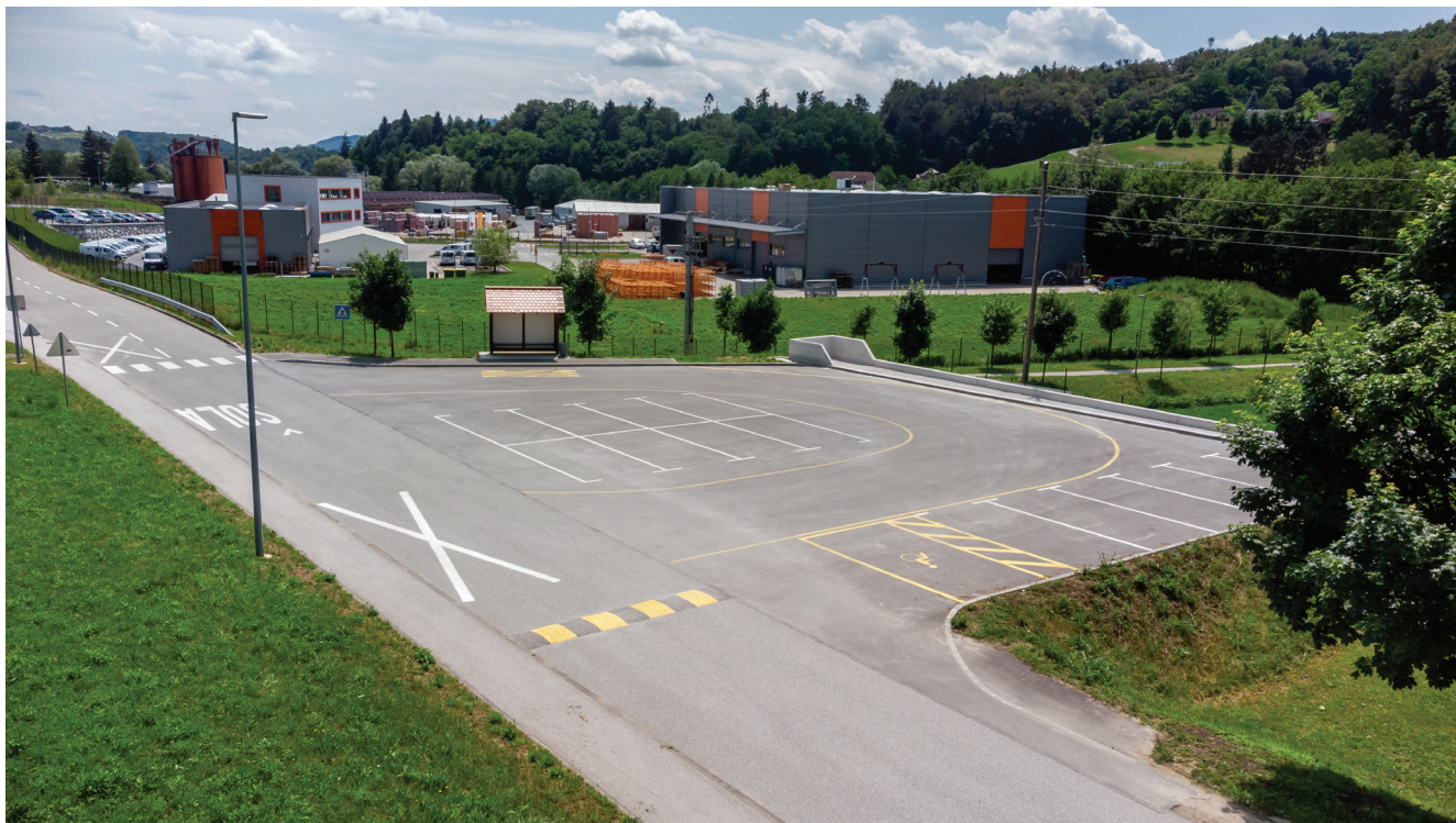
Pri POŠ Mestinje je urejeno parkirišče in obračališče za šolski avtobus z avtobusno postajo.
