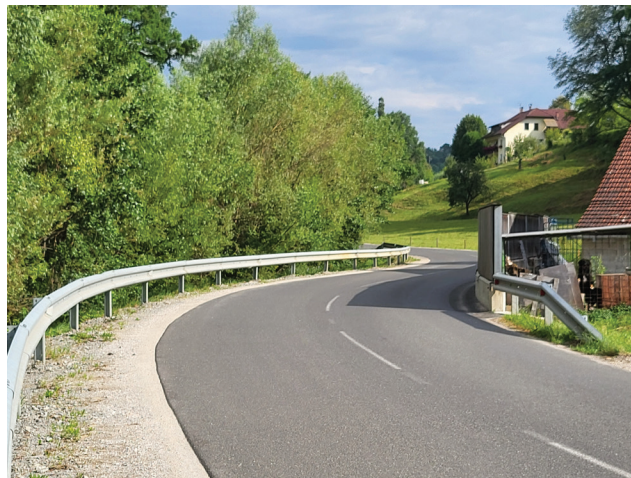
Nevaren odsek za pešce.
