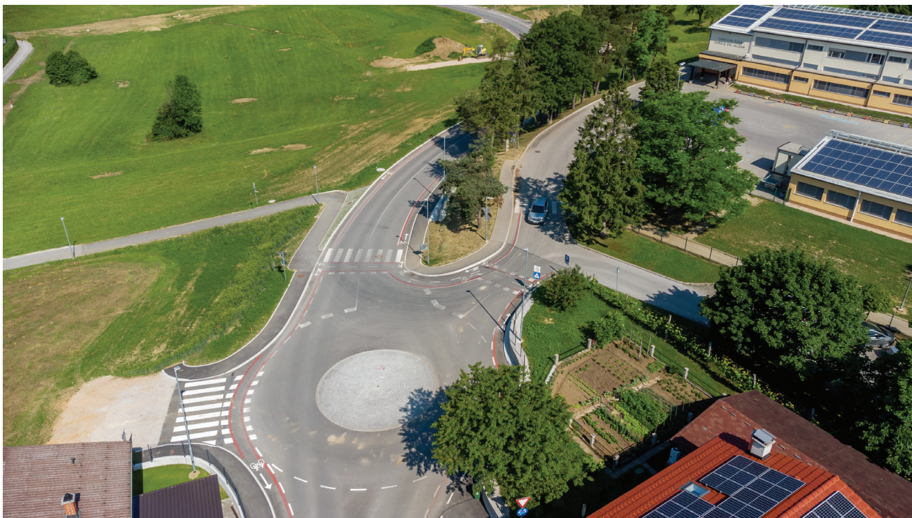
Z izgradnjo povezovalne ceste Dobrava se je spremenil prometni režim ob OŠ Šmarje pri Jelšah.
