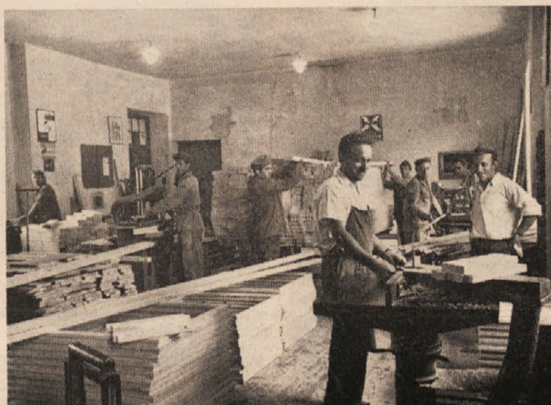
Strojna delavnica mizarstva nabasana s polizdelki opozarja na potrebo po rekonstrukciji, katere načrti so že pripravljeni
