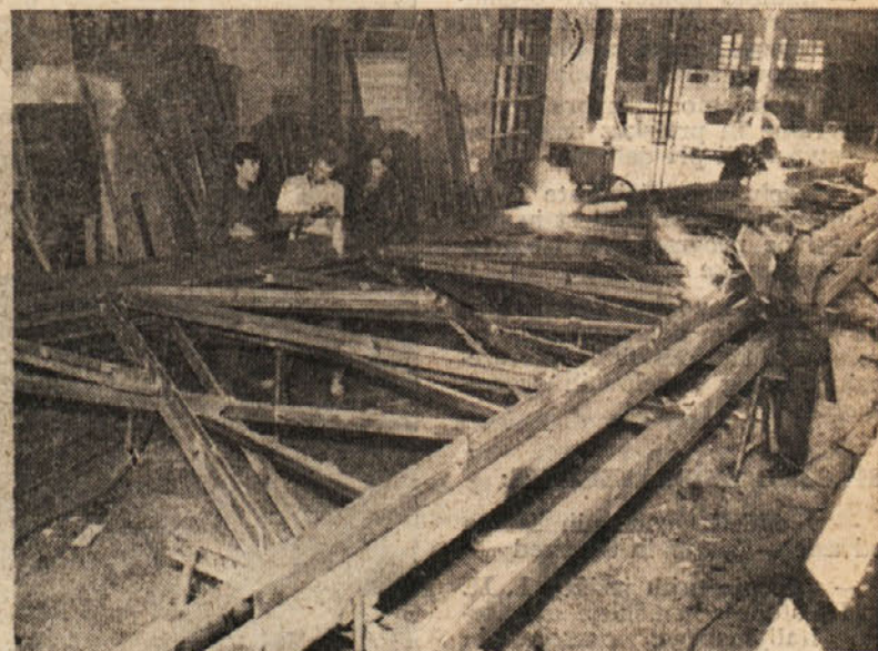
Del železnega rešetkastega nosilca za prekritje 24 m razpetine, izdelek stavbnega ključavničarstva
