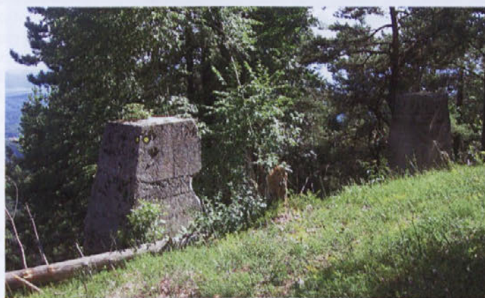
Na Grmado se lahko od kamnoloma odpravimo tudi prek Goljeka. Betonirani podstavki v gozdu pričajo o nemško-italijanski okupacijski meji, ki je bila določena leta 1941.
