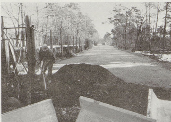
Dovozna cesta na gradbišče
