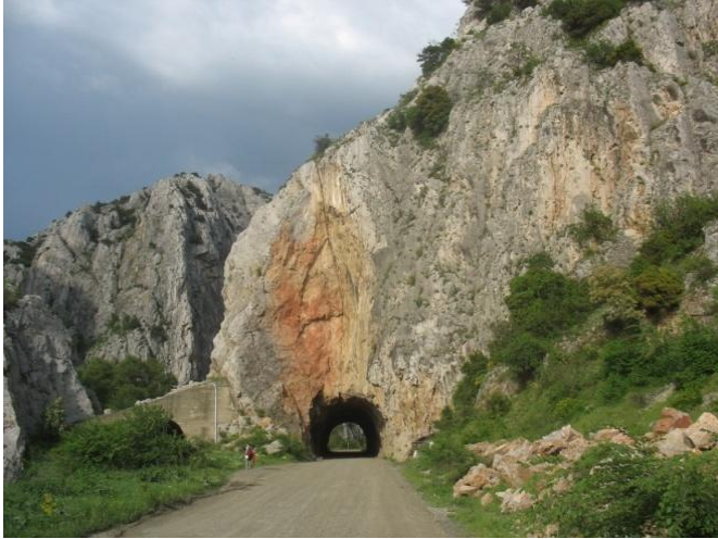
Slika 1: Demir Kapija – Tunel pred Jamo Bela voda. (foto: Primož Presetnik)
