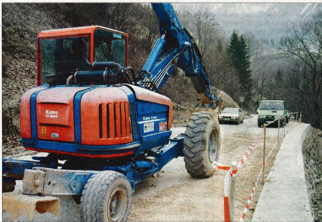
Pri vasi Čadovlje je že zgrajen nov oporni zid, ob njem pa so te dni nasipali in utrili makadamsko cestišče.
