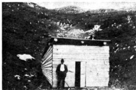
Začetek gradnje: zasilna baraka v globeli pod stavbiščem junija 1923 (Fot. R. Andrejka)
