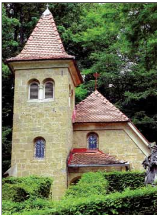
Slika 10: Kapela sv. Ana v Rogaški Slatini je bila leta 1904 zgrajena iz neometanega maceljskega peščenjaka. Figure 10: Chapel of St. Ana in Rogaška Slatina was built in 1904 from unplastered Macelj sandstone
